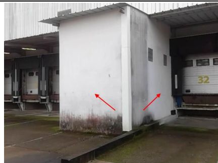
Photo n° PhA040 Localisation : Extérieur Ouvrage : 2 - Parois verticales extérieures et Façades - Façades lourdes y compris poteaux Partie d'ouvrage : Enduit extérieur (projeté, lissé ou taloché) Description : Enduit extérieur (projeté, lissé ou taloché)
