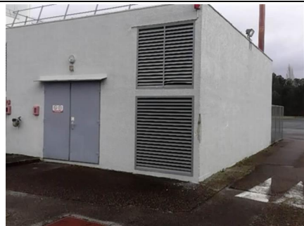
Photo n° PhA042 Localisation : Extérieur Ouvrage : 2 - Parois verticales extérieures et Façades - Façades lourdes y compris poteaux Partie d'ouvrage : Enduit extérieur (projeté, lissé ou taloché) Description : Enduit extérieur (projeté, lissé ou taloché)
