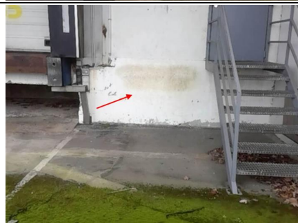
Photo n° PhA041 Localisation : Extérieur Ouvrage : 2 - Parois verticales extérieures et Façades - Façades lourdes y compris poteaux Partie d'ouvrage : Peinture sur béton Description : Peinture sur béton
