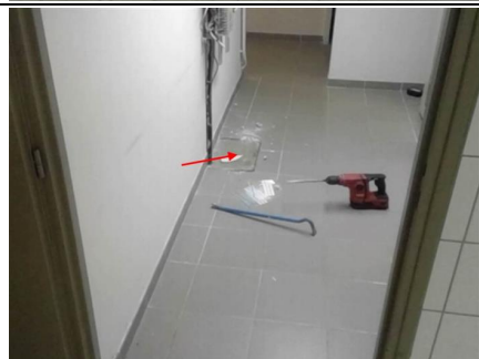
Photo n° PhA007 Localisation : Bureaux - RDC Ouvrage : 5 - Planchers et planchers techniques - Revêtements de sols Partie d'ouvrage : Colle de carrelage Description : Colle de carrelage
